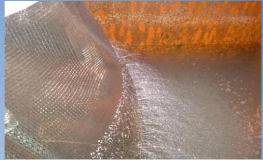
ノッチタンク内部のエコポーチによる脱水状況。
